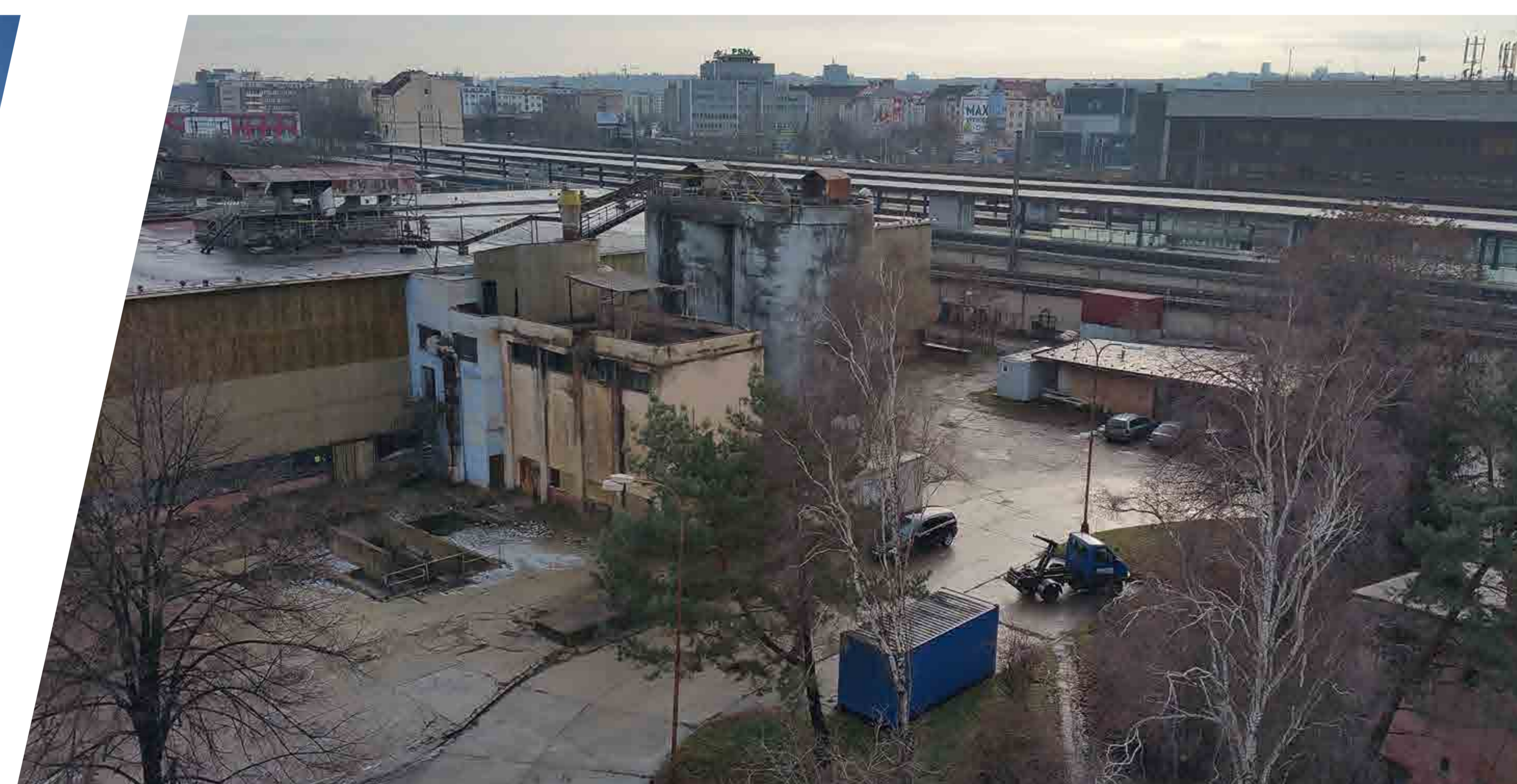
Výrobní hala se silem na cement, zásobníkem kameniva a kalové jímky.
