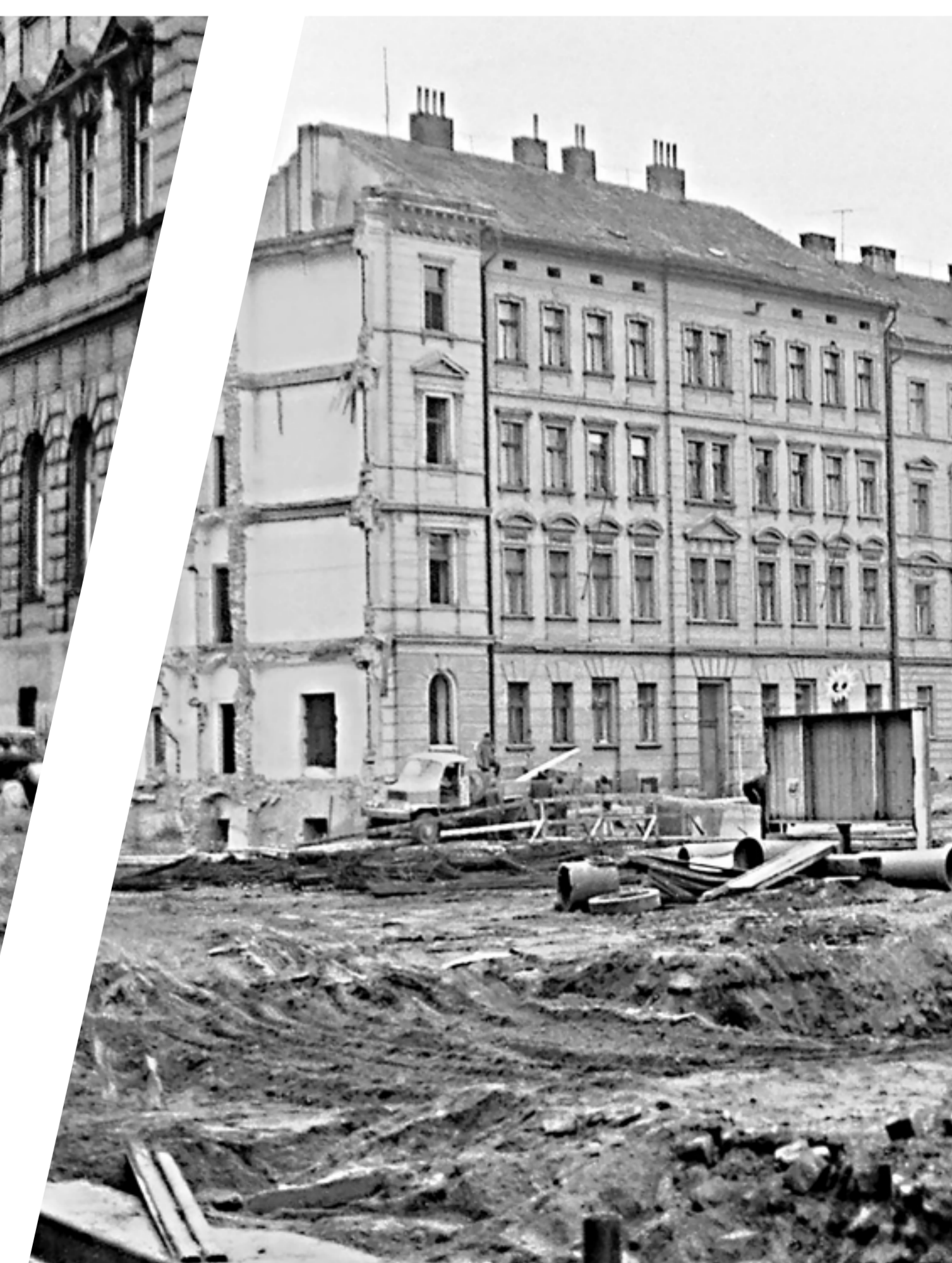
Demolice kvůli novému nádraží, metru a magistrále 1978-1984.
