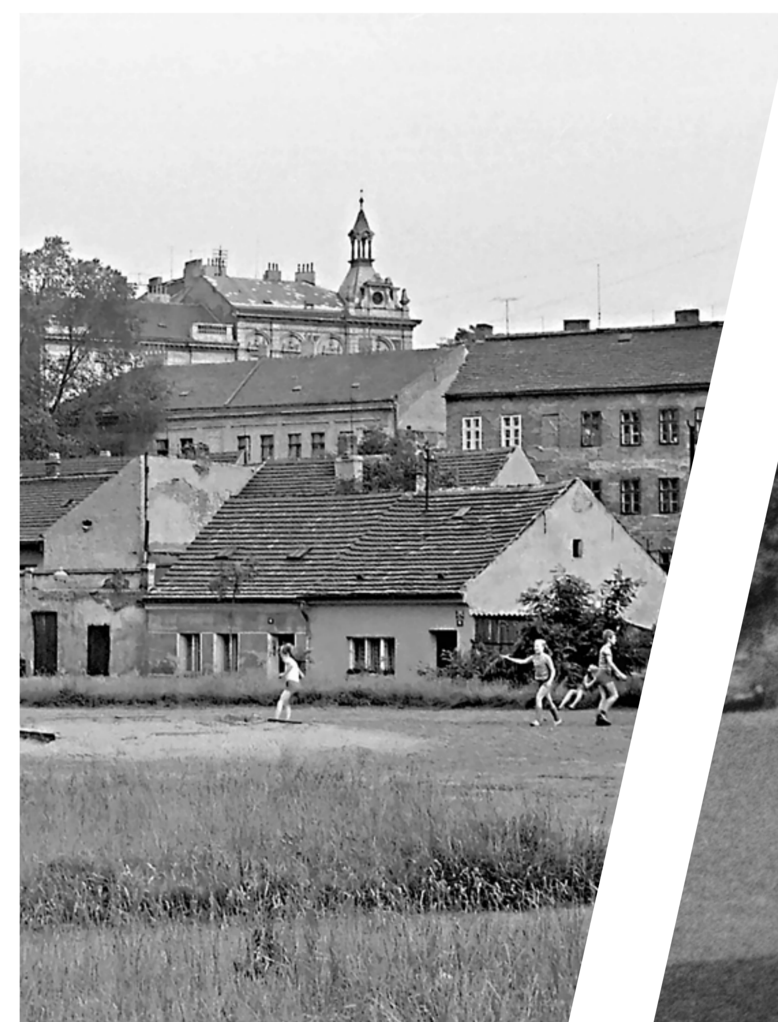
Hřiště na zelené louce v srdci starých Holešovic.
