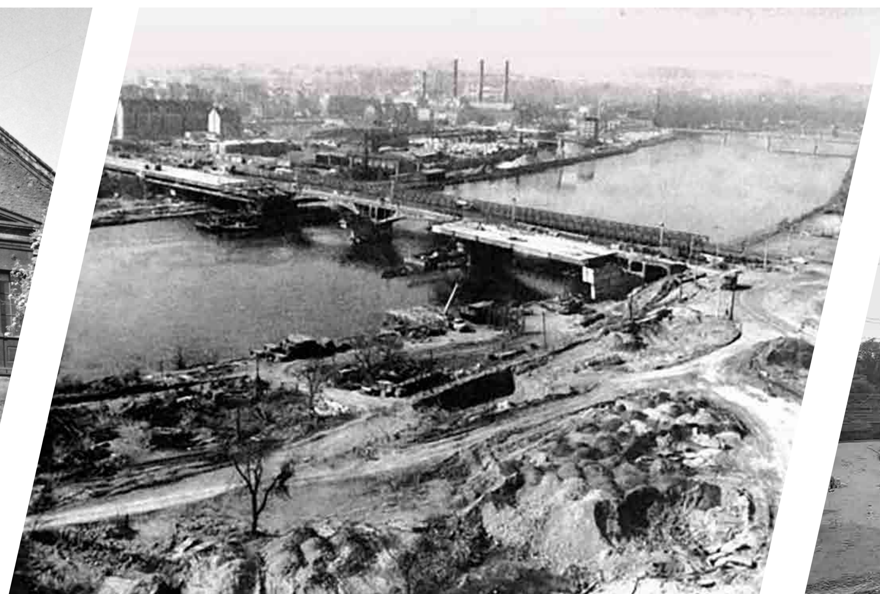
Stavba nového mostu Barikádníků na místě původního Trojského mostu. Pohled od Pelc Tyrolky k Holešovicím. Nábřeží starých Holešovic již nahradila panelárna.
