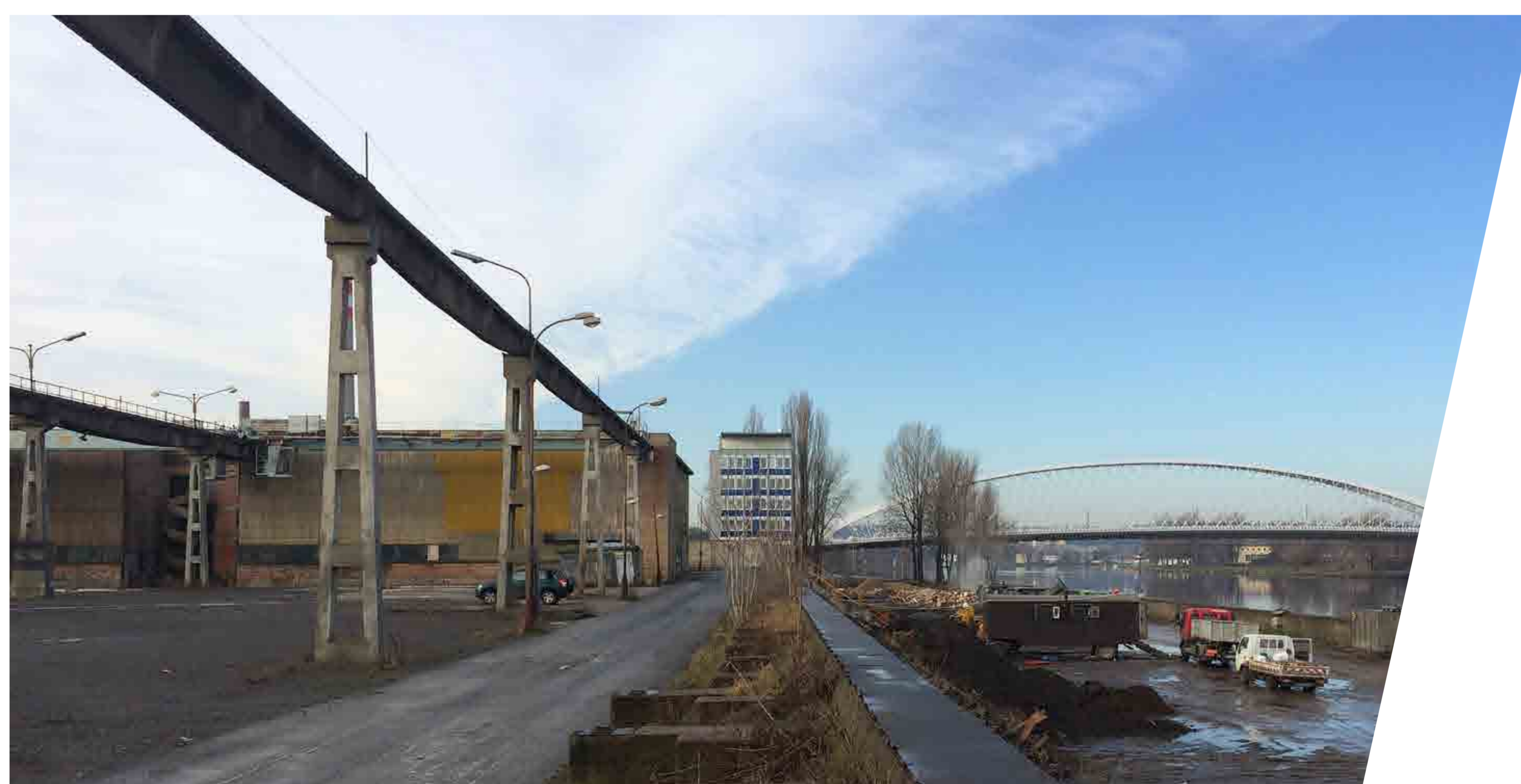
Jeřábové dráhy mostových jeřábů pro obsluhu skládky hotových výrobků.
