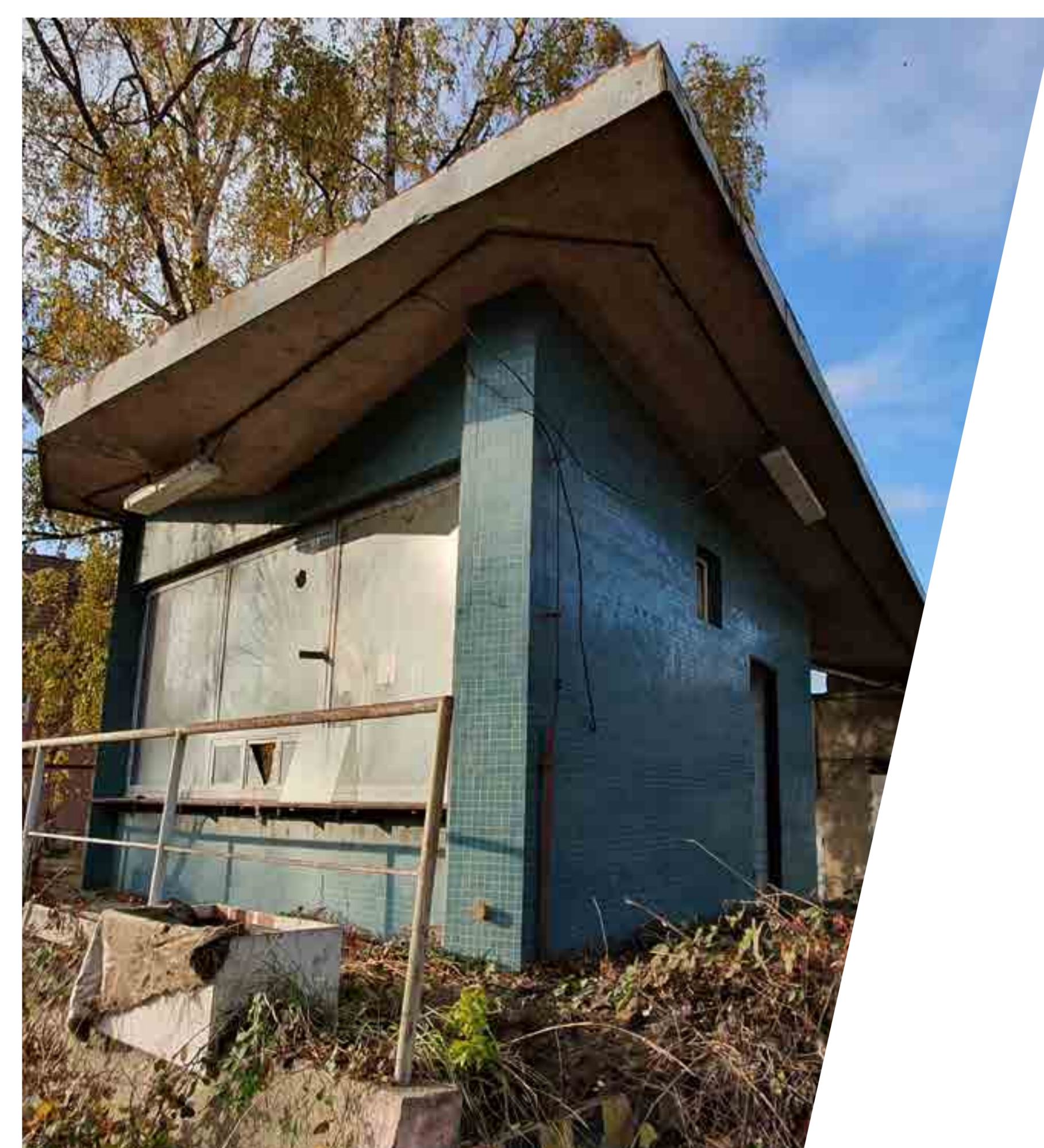
Vrátnice bývalé armovny.
