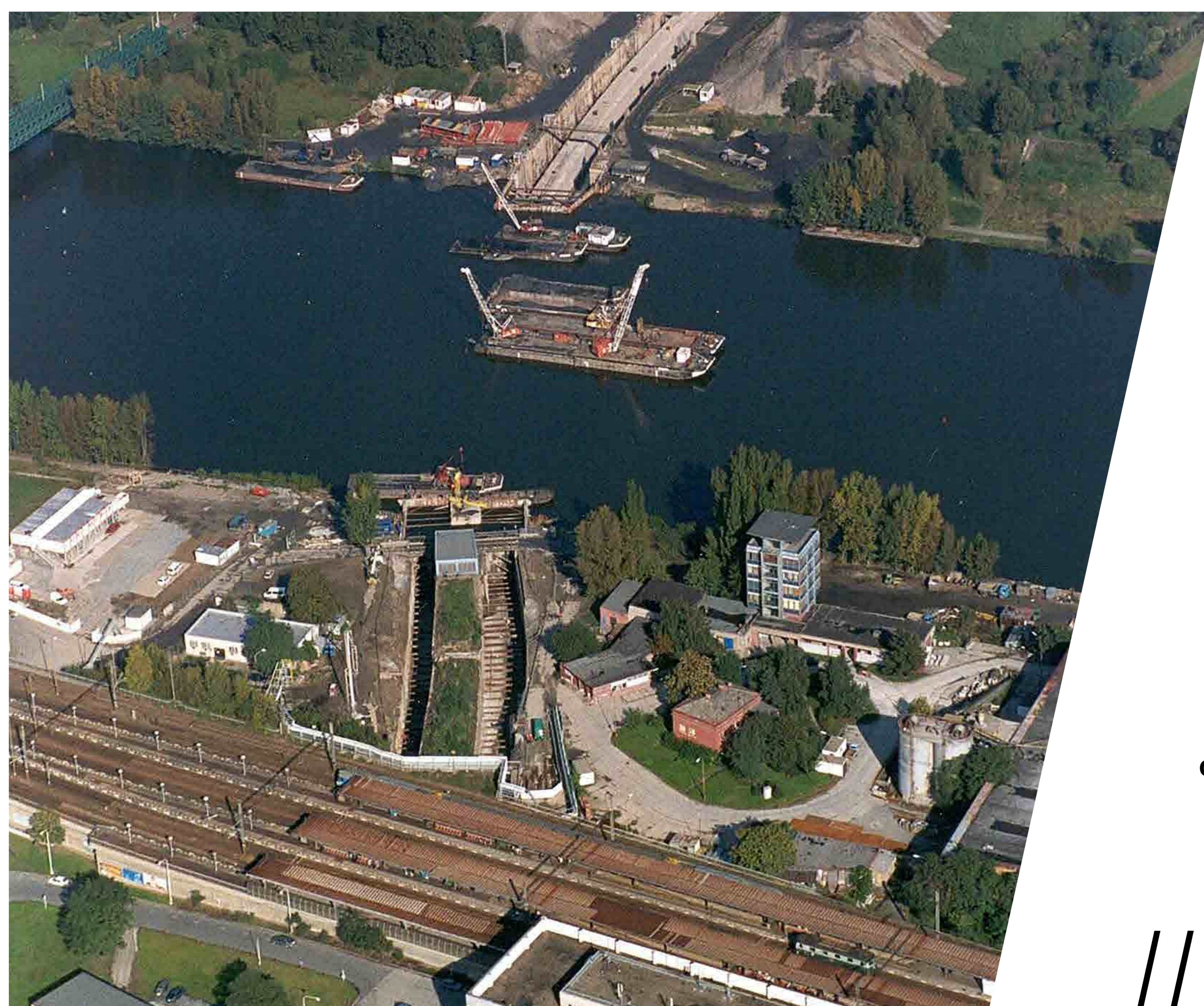
2003 - stavba metra směr Ládví
