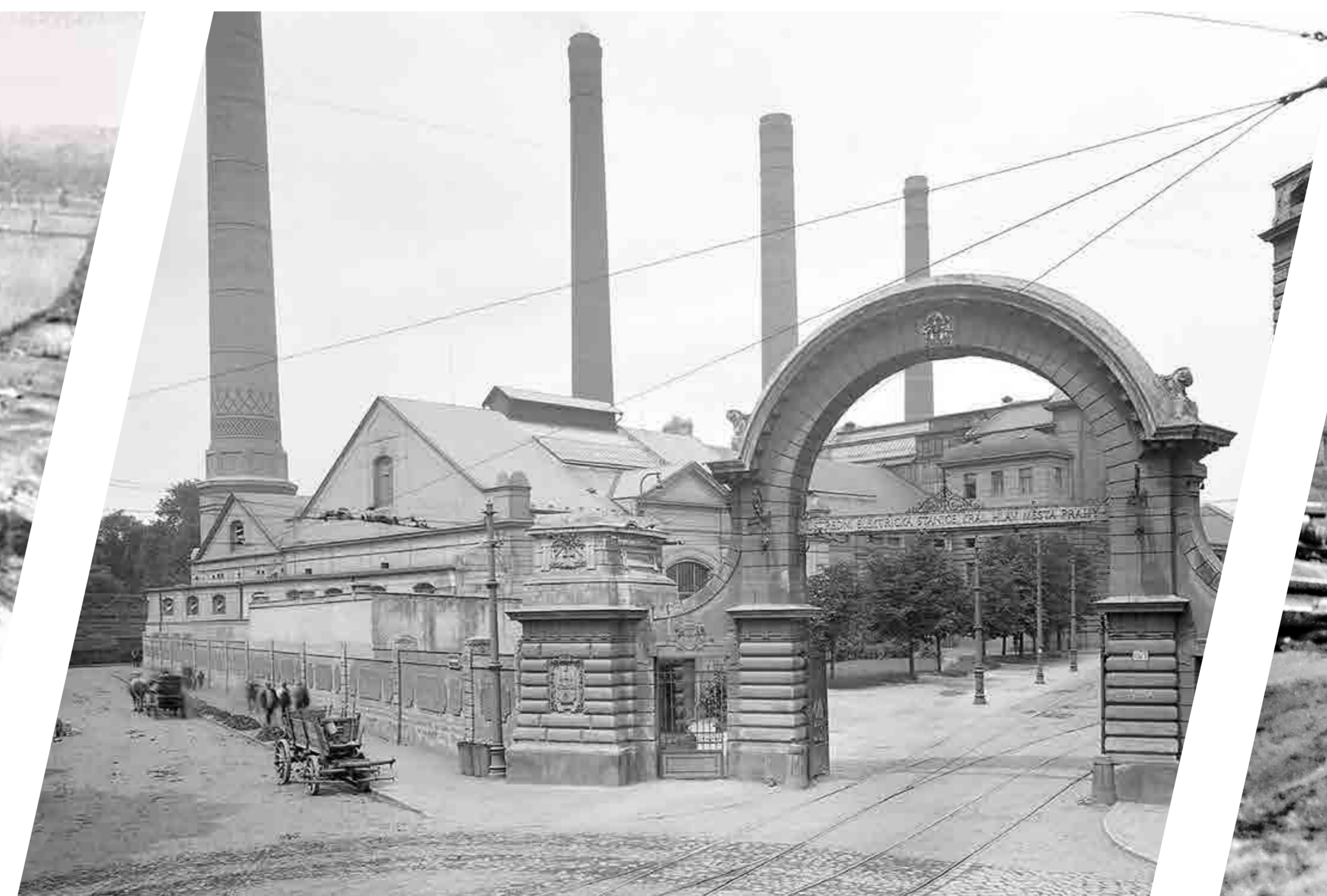
Vjezd do areálu Ústřední elektrické stanice v Holešovicích kolem roku 1914.
