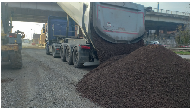
Materiál přivezený z betonárny na stavbu
