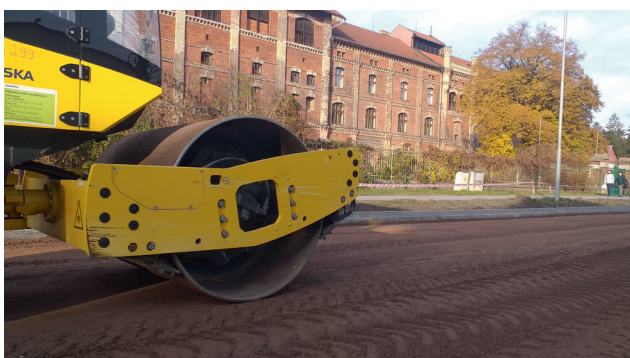
Hutnění rozprostřené vrstvy vibračním válcem
