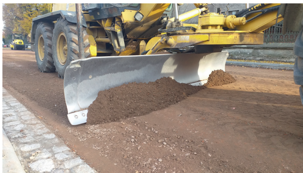
Rozprostření grejdrem do požadované výšky a spádu
